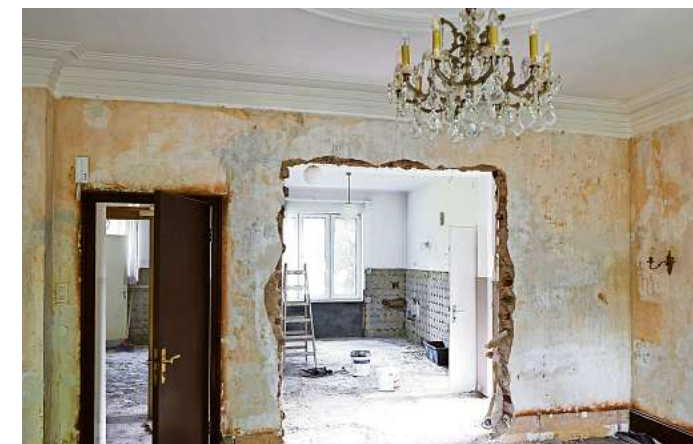
Die Renovierung der Villa Kieserling ist angelaufen. Mitgliedsunternehmen sollen hier Veranstaltungen abhalten können.
