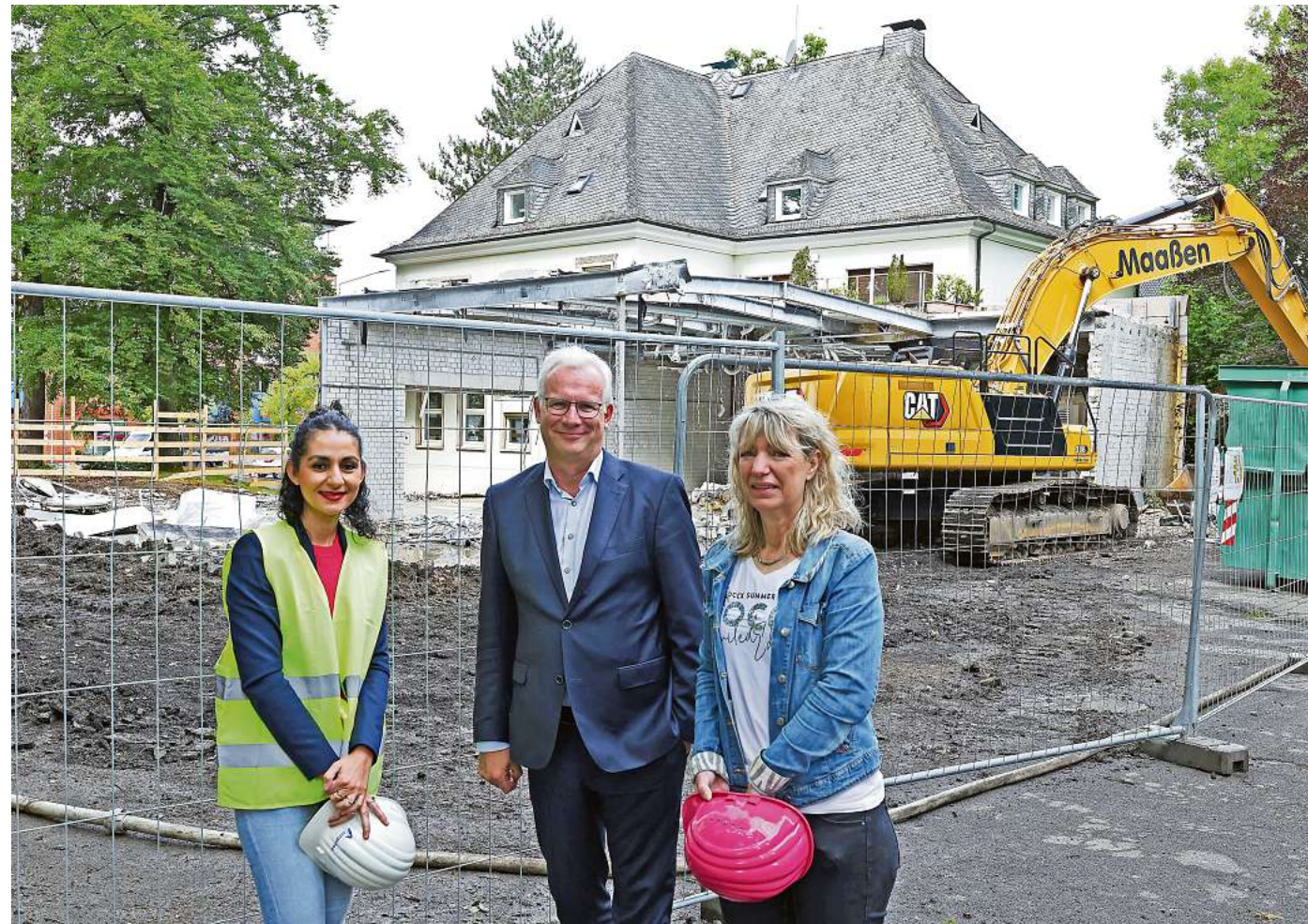
Hier entsteht die neue Kindertagesstätte: Architektin Leila Abbassian (v. l.), Michael Schwunk und Bauleiterin Stefanie Lessenich vor dem niedergelegten Kassengebäude der Sparkasse. Fotos: Christian Beier
